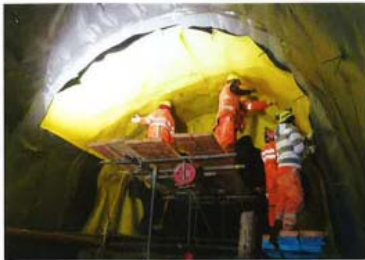
Sika 社製防水シート施工状況
