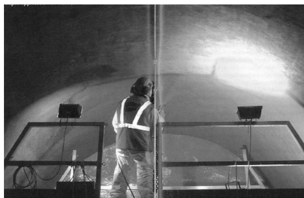
吹付け防水の早期施工
