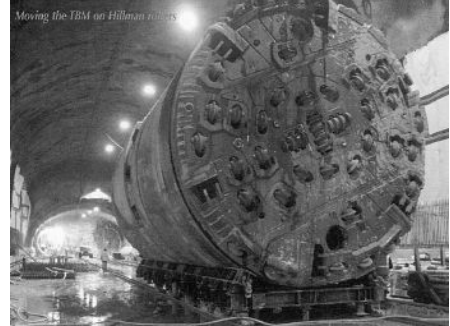
坑内運搬中のTBM
