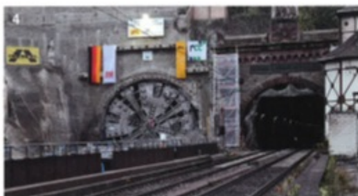
図4 コッヘム坑口(左新トンネル、右旧トンネル)
