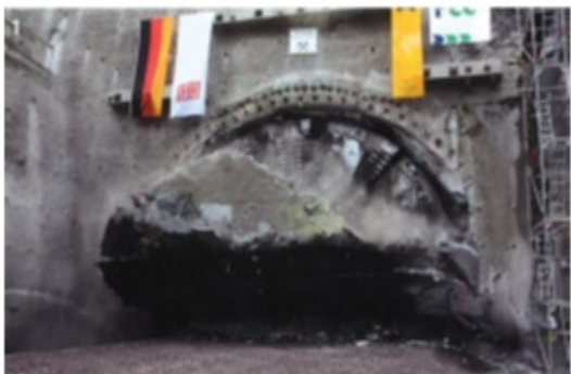
図1 コッヘルム坑口の貫通
