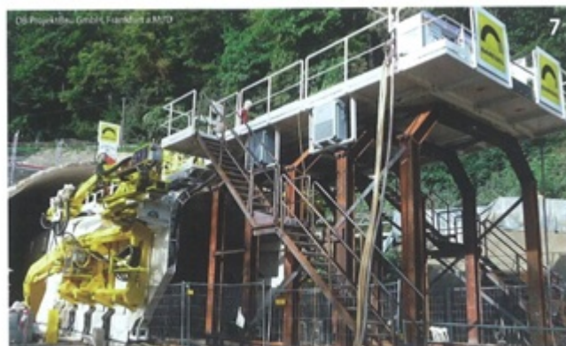
Tunnelvortriebsportal für die Aufweitung des Langenauer und Holricher Tunnels Tunnel driving portal for enlarging the Langenauer and Holrich Tunnels
