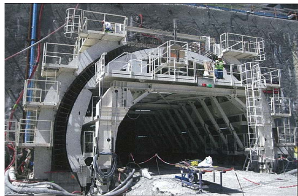
図-2 ガントリー一体型の型枠
