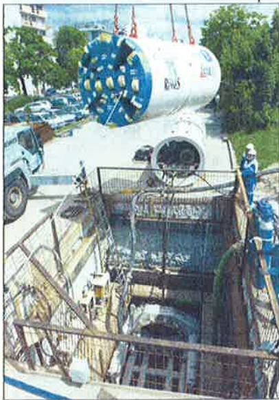
写真 ヘレンクニヒト社製推進機 (AVN 1600TC)
