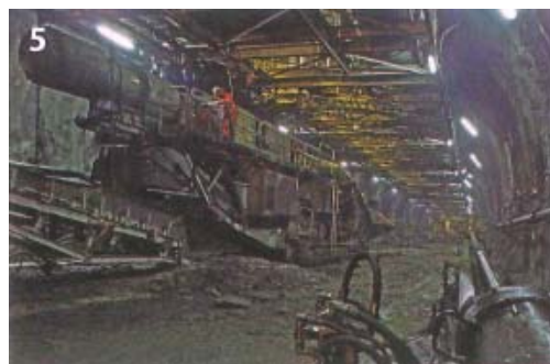
ベンチ・インバート掘削エリアに吊下げられた掘削プラットフォーム、ジョー・クラッシャーと牽引コンベア
