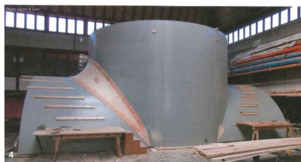
連絡坑の中央にある排気ギャラリー上部の型枠。
