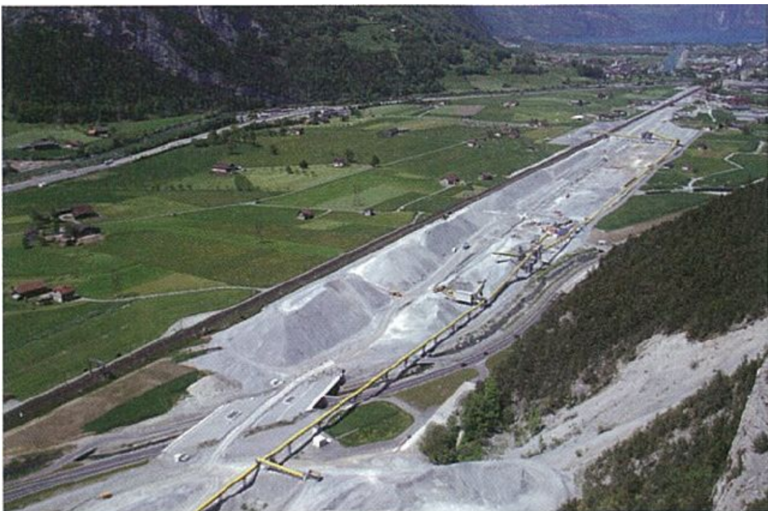
1 Baustelle der Nordzufahrt im Urner Reusstal
