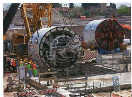
地上での組立て完了後、
