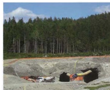
Snaraberg トンネル坑口
