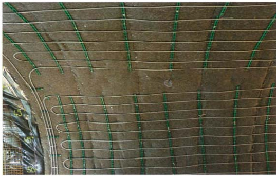
アブソーバーシステム設置状況
