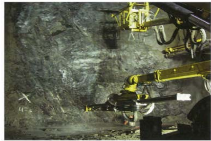
Kroksberg トンネルの削孔状況
