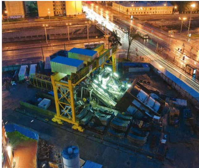
図-1 サンクトペテルブルグ中心にあるエスカレーターのための斜坑
