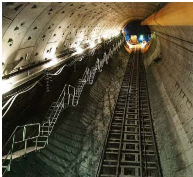
図-2 斜坑の状況
