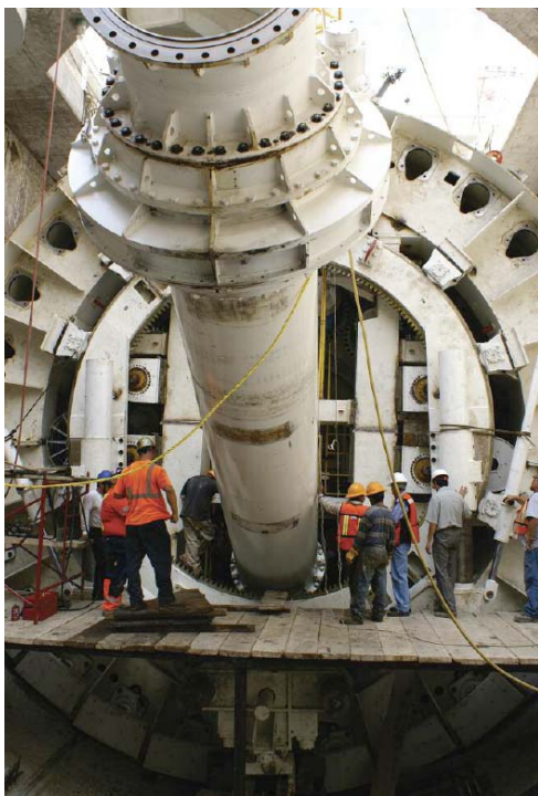
写真-1 TBM 掘進機組立状況
