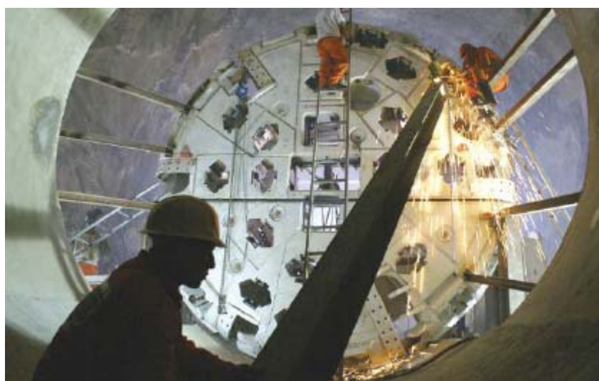
図-2 TBM 製作状況
